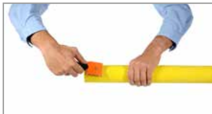
5. Rasar la zona de soldadura del tubo.
