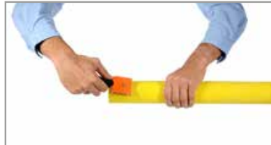
5. Rasar la zona de soldadura del tubo.
