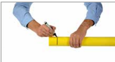
7. Marcar la profundidad de inserción del tubo.
