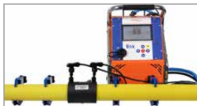
11. Inicio de la soldadura.
